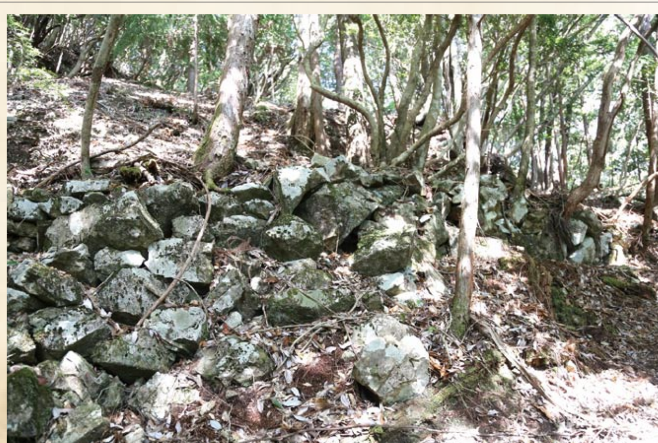
路盤崩壊を防ぐ石積
